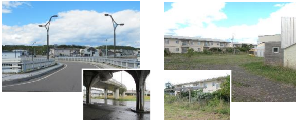
人工地盤は、旧市街地を 6m 嵩上げる漁業集落整備事業で整備された住宅地につながる
